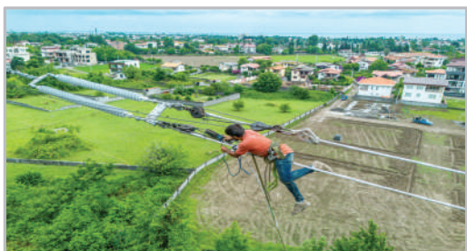
ابریروزه خط انتقال برق شمال
